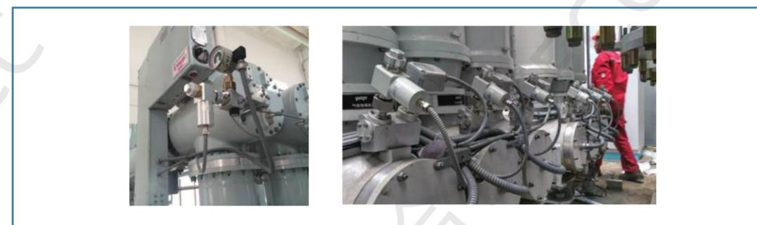
变压器局部放电在线监测系统现场案例
